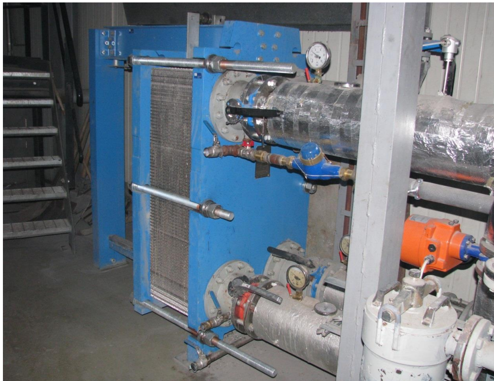
Siltummainis ar zemu hidraulisko pretestību
